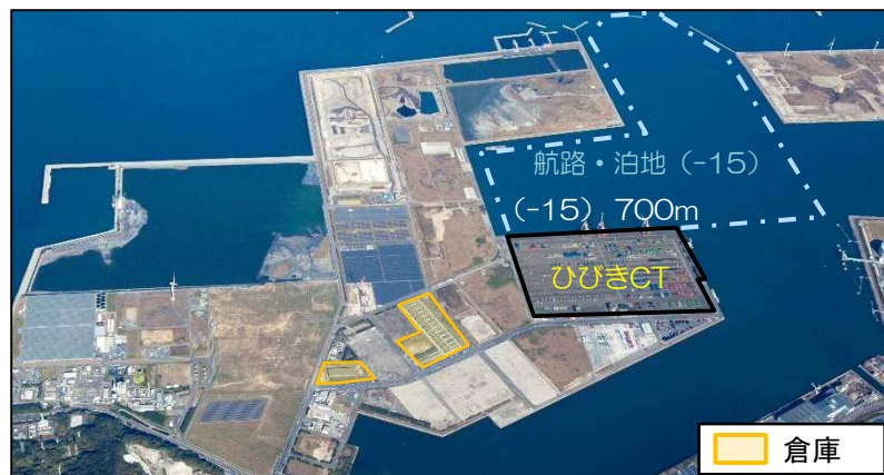
図 4-3 ひびきコンテナターミナル周辺の倉庫の立地状況
