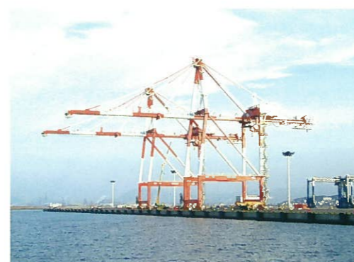
ガントリークレーン
